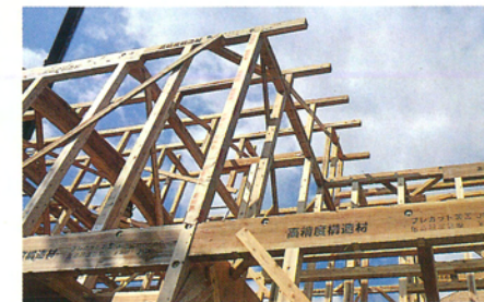
ミリ単位の精度・強度を誇る高精度構造材での上棟
