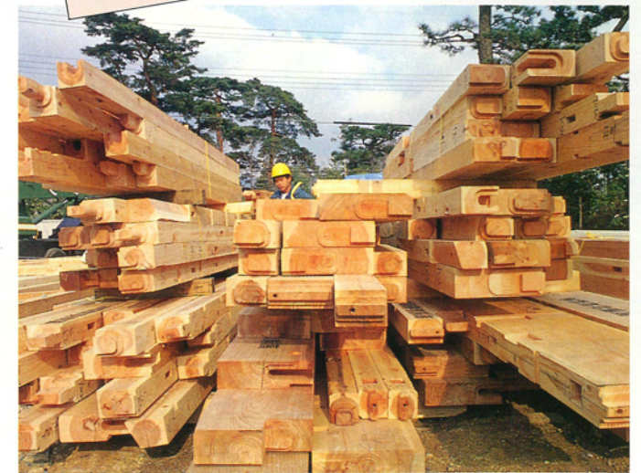
現場に配送されたプレカット材(高精度構造材)
